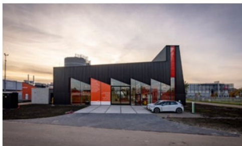
Warmtecentrale WarmteStad in Groningen
