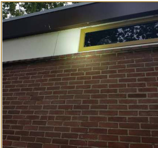
Afbeelding. 2.9: De dakrand sluit naadloos aan op de muur.
