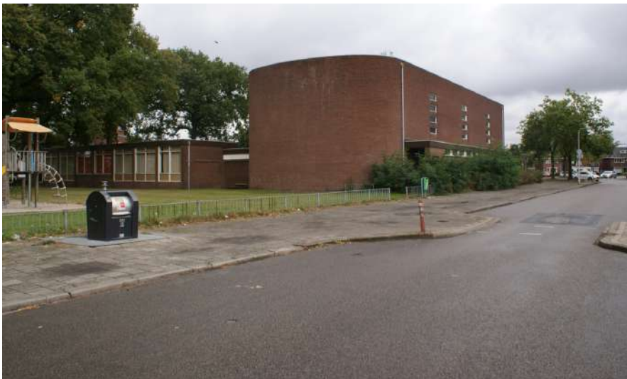
Afb. 12 - Kenmerkend voor het kerkgebouw is het contrast tussen het grote gesloten volume van de kerkzaal ten opzichte van de transparant vormgegeven ontmoetingsruimten.
