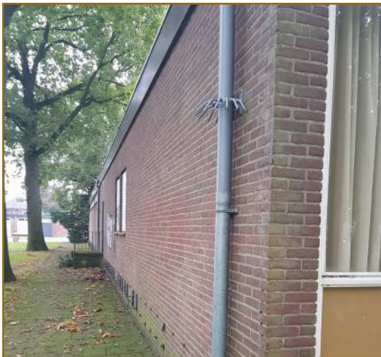
Afbeelding. 2.3: De noordelijke kant van het gebouw.
