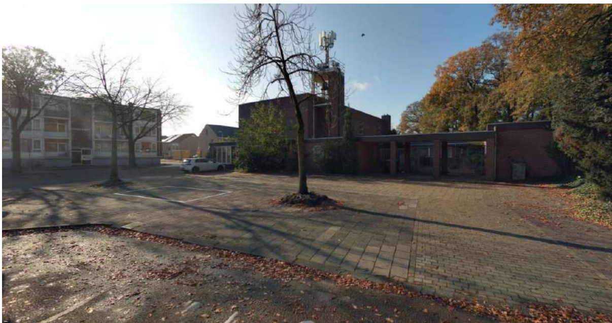
Afbeelding 3.5: zicht op de projectlocatie vanaf de Rembrandtlaan
