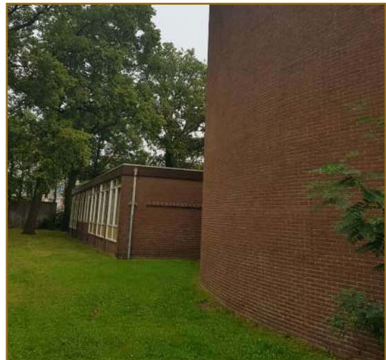
Afbeelding. 2.4: De westelijke kant van het gebouw.
