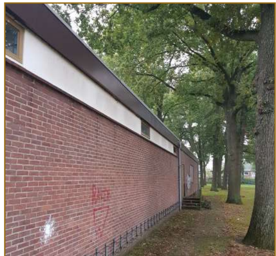
Afbeelding. 2.10: Foto van de noordelijke kant van het gebouw met de grote bomen die daar staan.
