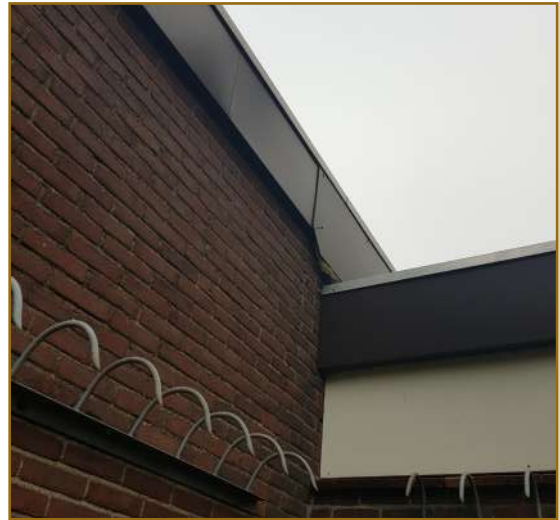
Afbeelding. 2.8: De dakrand sluit naadloos aan op de muur.
