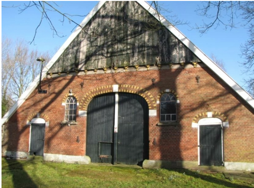
Afbeelding 3.2: De voorkant van de karakteristieke schuur
