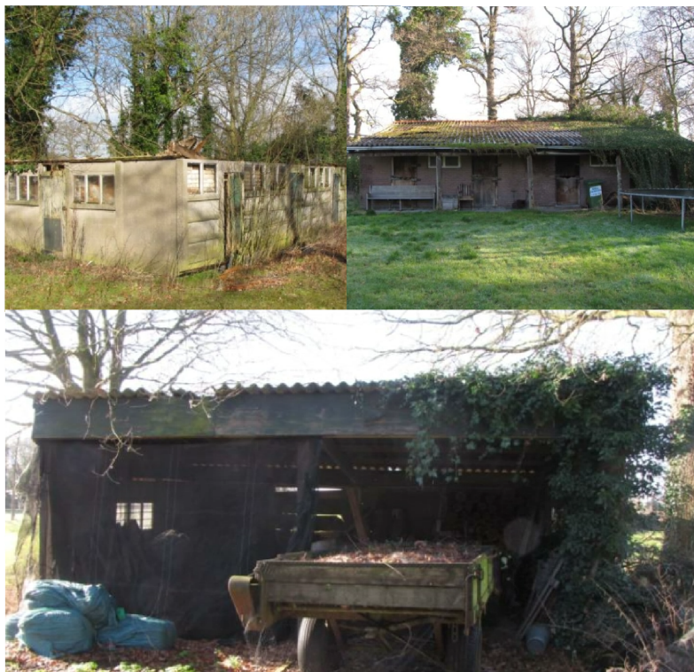
Afbeelding 3.3: Twee bijgebouwen op het erf (linksboven de varkensschuur en onder de wagenberging) en de veldschuur in het bijbehorende weiland (rechtsboven)
