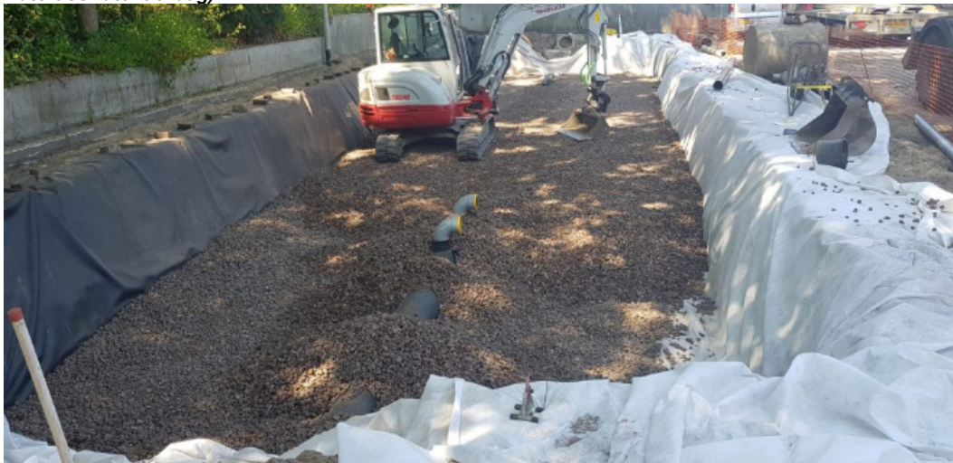
Afbeelding 2: voorbeeld van een lava-pakket welke als berging gaat dienen onder de wegverharding.
