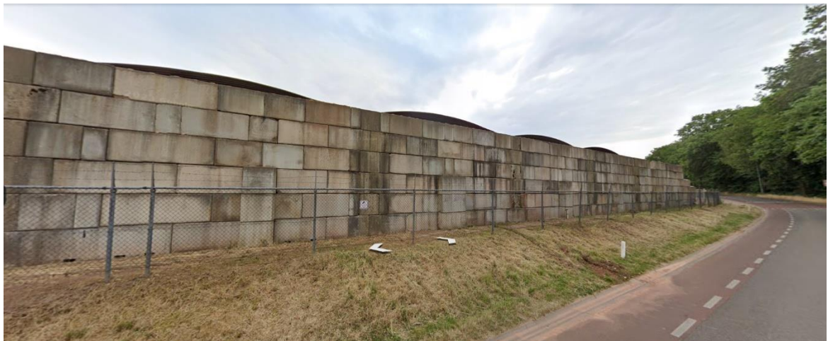
Afbeelding 5: Bestaande situatie keerwanden gezien vanaf de St. Jorisstraat in zuidelijke richting
