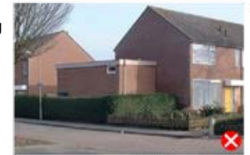
zijaanbouw te hoog
