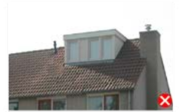
te hoog op het dak, profiel van de woning wordt aangetast
