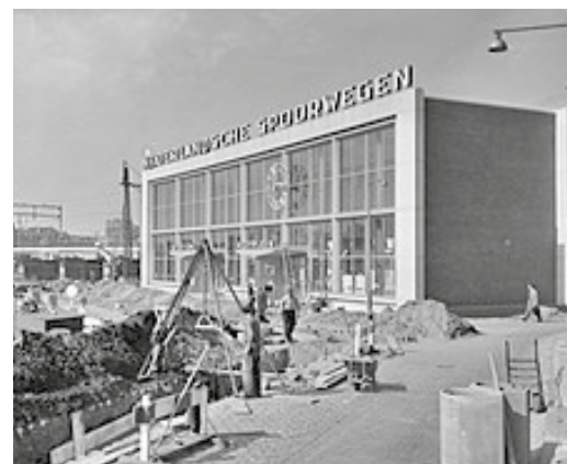
Figuur 7. Voormalig naoorlogse station Hofbogen is gesloopt
