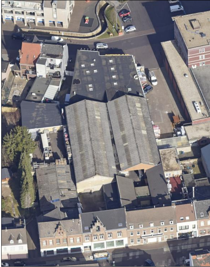
Foto's bestaande situatie
