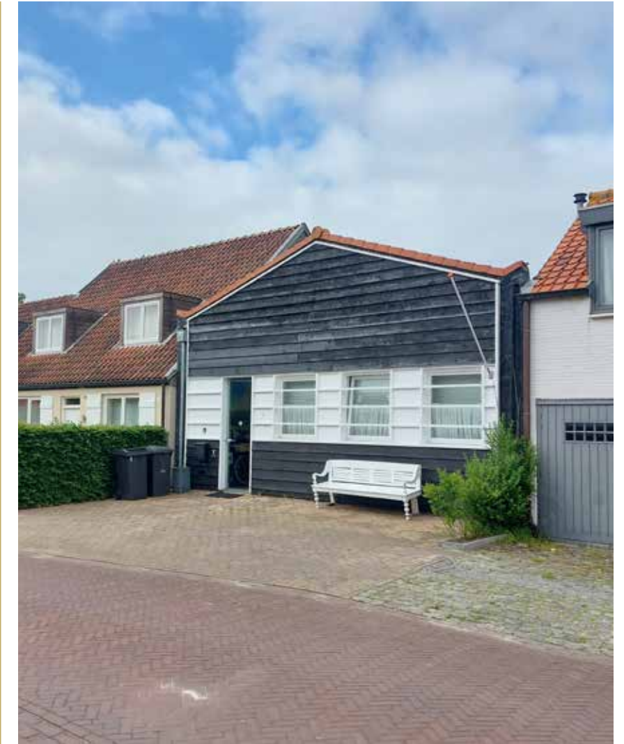
Het voormalige kerkgebouw van de Vrije Evangelische Gemeente in Retranchement
