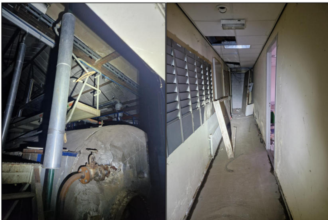
Figuur 2.5 Binnenruimtes Gebouw D met oude fabrieksinstallaties en oude kantoorruimtes.
