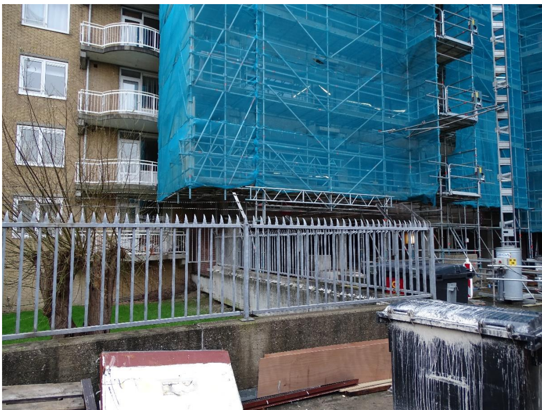
Aangrenzende bebouwing in de steigers (plan Nieuw Hoboken), gezien in oostelijke richting.
