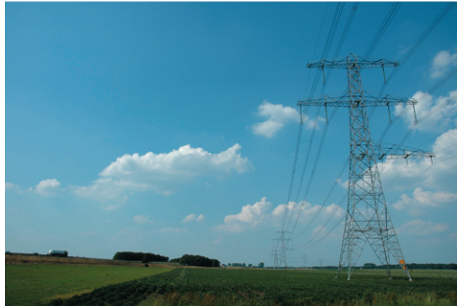
Afb. 5 Nieuwe infrastructuur in beekdal Sleenerstroom
