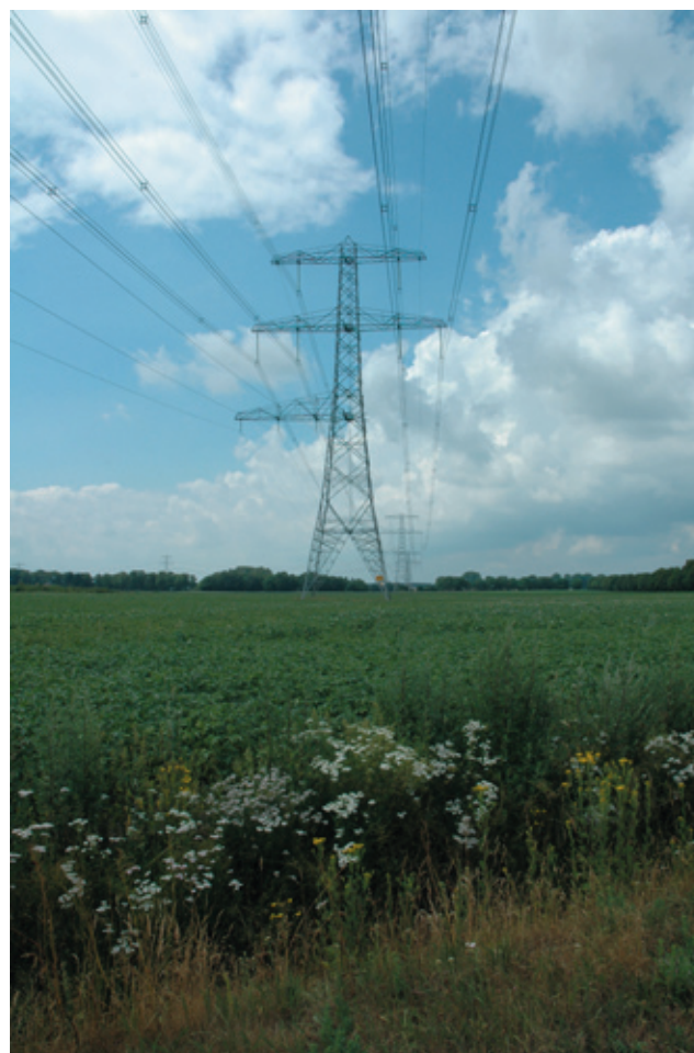
Afb. 68 Hoogteverschil zichtbaar door hoogspanningsleiding
