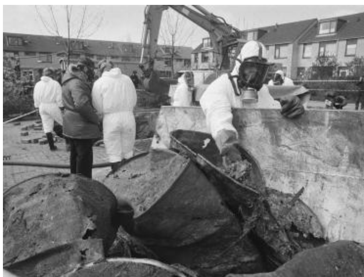
Chemische stoffen in Lekkerkerk worden opgegraven.
