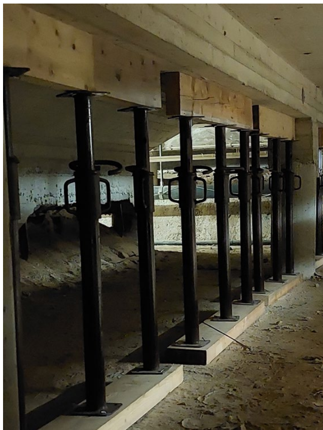
Figuur 4.2: De gestutte constructie
