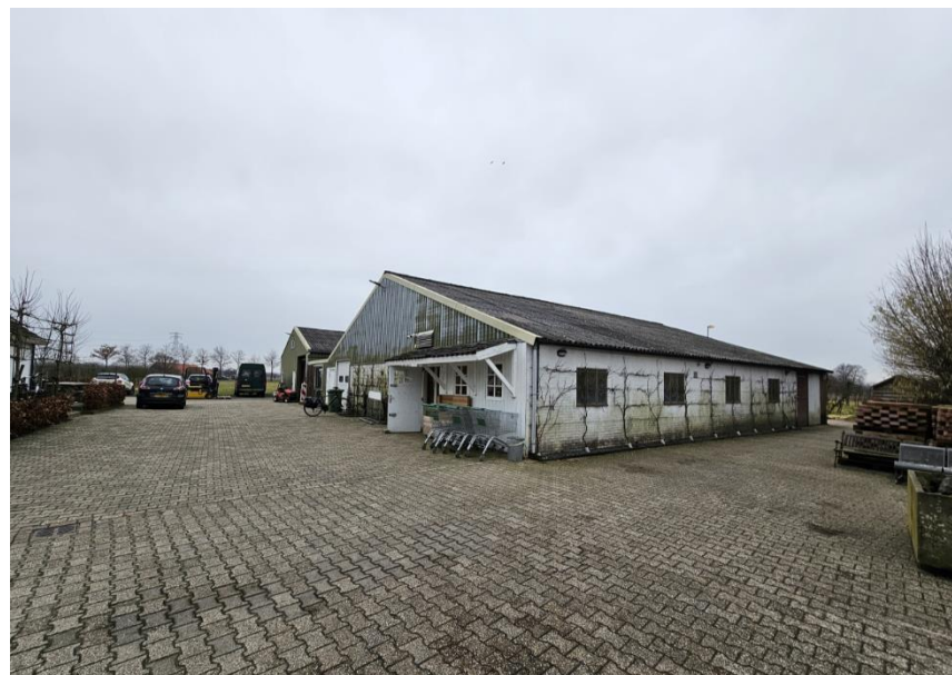
Figuur 5: Zuidwest aanzicht van de landwinkel in het zuiden van het plangebied
