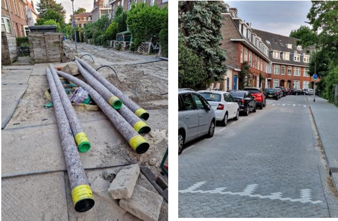
Figuur 56 Links: DI-leidingen t.b.v. de Gravenbuurt. Rechts: Een waterdoorlatende bestrating.
