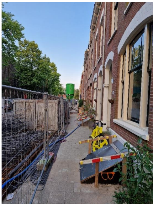
Figuur 36 Funderingsherstel aan de Kootsekade. Bouwjaren van deze woningen zijn 1903-1905 (Margrietlaankwartier, 2023)
