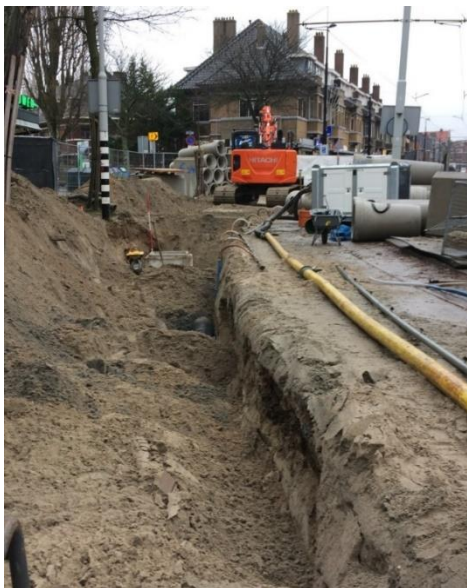
Figuur 15 . De eeuwenoude kleidam ligt nog steeds onder het wegdek van de huidige Kleiweg. Bij werkzaamheden aan het riool en de aanleg van een DI-leiding werd deze dam blootgelegd. Op de foto is de dam duidelijk waarneembaar. Deze is niet verzakt zoals het wegdek in de Elektroweg. De werkzaamheden op de foto vinden plaats ten Noorden van de Kleiweg. Dus in de voormalige polder Berg en Broek waar nu het Statenlaankwartier-de Laantjes liggen.
