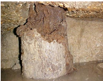
Figuur 17 Een door droogstand aangetaste houten paalkop.
