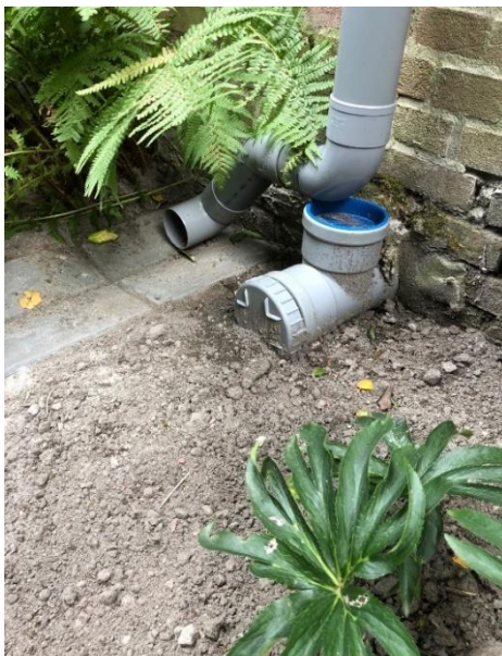
Figuur 50 Het loskoppelen van regenpijp
