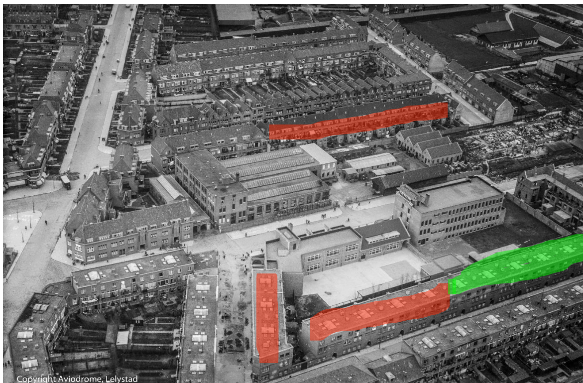
Figuur 25 De rood gemarkeerde panden zijn verzakt en afgebroken: bovenaan de foto is de Baroniestraat, het horizontale blok onderaan de foto is de Lisbloemstraat, het verticale blok betreft de Margrietstraat. De Duizendschoonstraat is niet op deze foto te zien. Groen gemarkeerd is het huizenblok aan de even zijde dat is voorzien van funderingsherstel.
