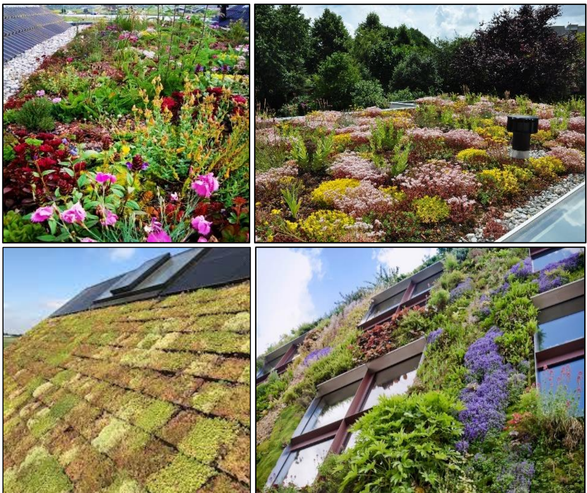
Figuur 4.6. Boven: Twee bloemrijke groene daken met elk een andere vegetatie samenstelling; linksonder: groene dakpannen; rechts onder: een groene gevel met een combinatie van (jaarrond) groene planten en bloemdragende planten.
