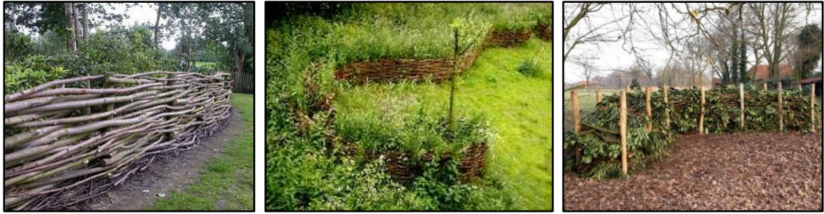
Figuur 4.7. Diverse varianten van een takkenril. In de linker twee voorbeelden is de takkenril gecombineerd met vegetatie.
