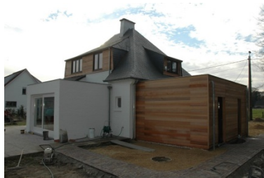
Afbeelding 9 aanbouw voldoet niet
