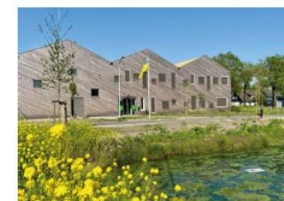
Nieuw grondstoffencentrum aan de Ekkelkamp gerealiseerd
