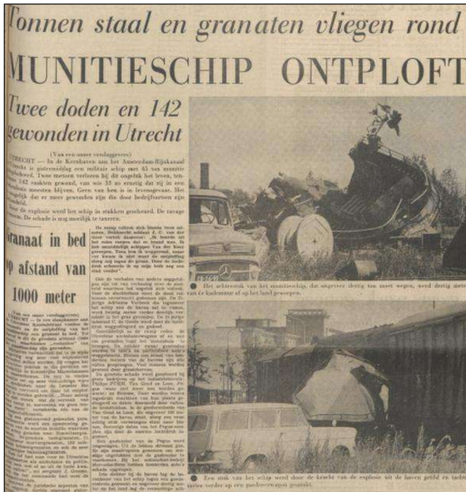
Afbeelding 4.1.2: Het achterschip van het ontplofte munitieschip, ruim 30 ton zwaar, werd 30 meter op het land geworpen (bovenste foto). De boeg kwam ruim 100 meter op het land, tegen een treinwagon (onderste foto). Bron: Trouw 13 juni 1967
