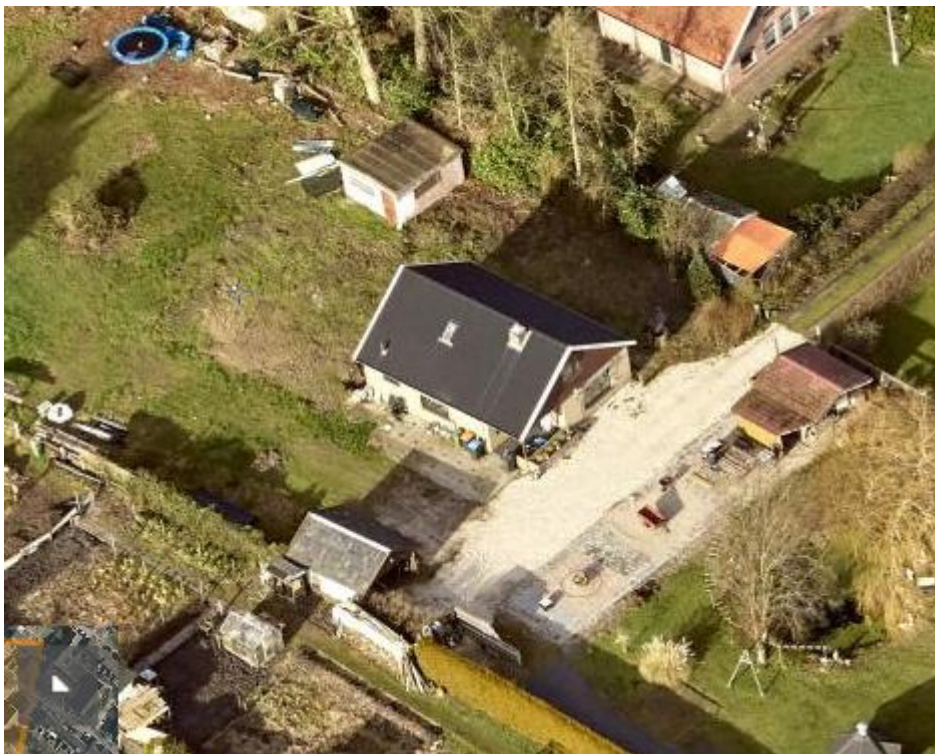
Figuur 1.3 Luchtfoto van het projectgebied (uit deze luchtfoto blijkt dat de schuur inmiddels is gesloopt)
