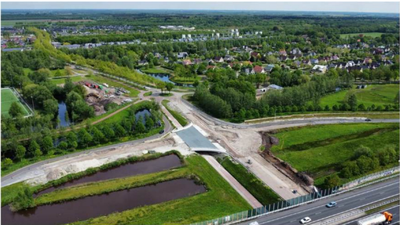
Vogelvluicht van de entree van de Oranje Nassaulaan ten tijde van de reconstructie van de op- en afritten
