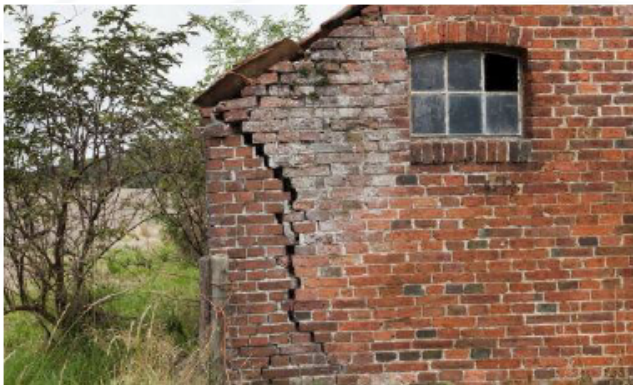
V-vormig scheur
