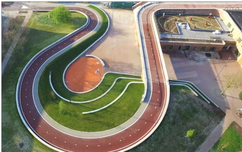
Foto rechts: Heringerichte Victor Hugoplantsoen met aanlanding Dafne Schippersbrug
