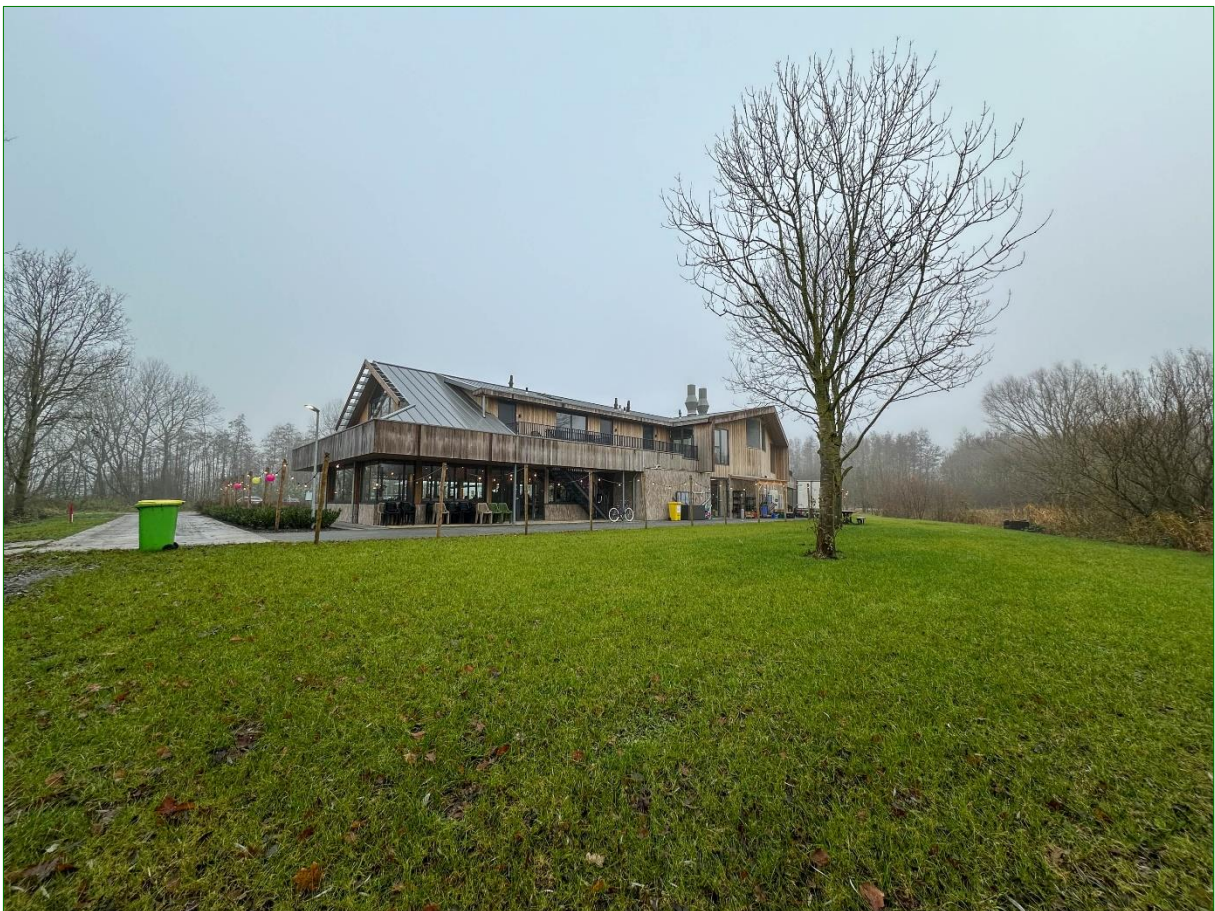
Het nieuwe restaurant inclusief zes short stay appartementen gezien vanuit noordoostelijke richting.
