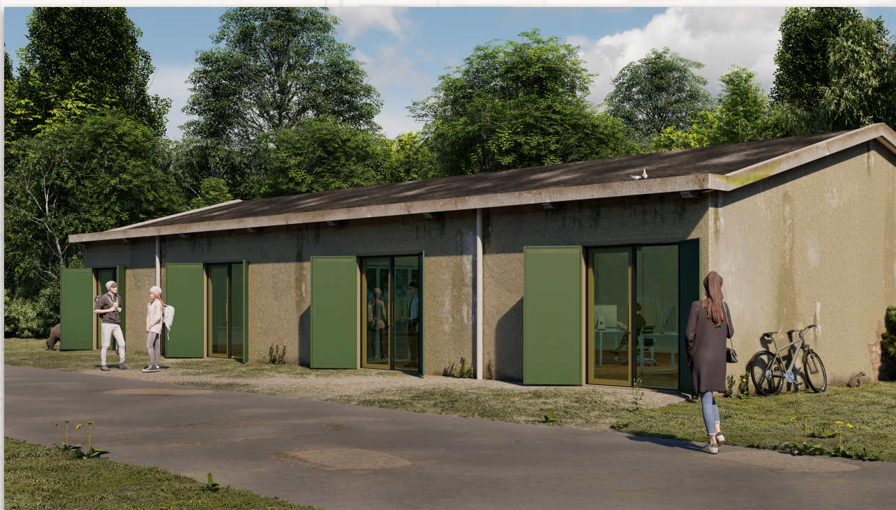
Globale impressie van een model A munitiemagazijn na de herbestemming tot verhuurbare ruimte. Het uiterlijk is vrijwel ongewijzigd gebleven, terwijl met de houten binnenbouw een comfortabele ruimte is gecreëerd. Licht treedt binnen via de glazen deuren en daklichten in het achterdak.
