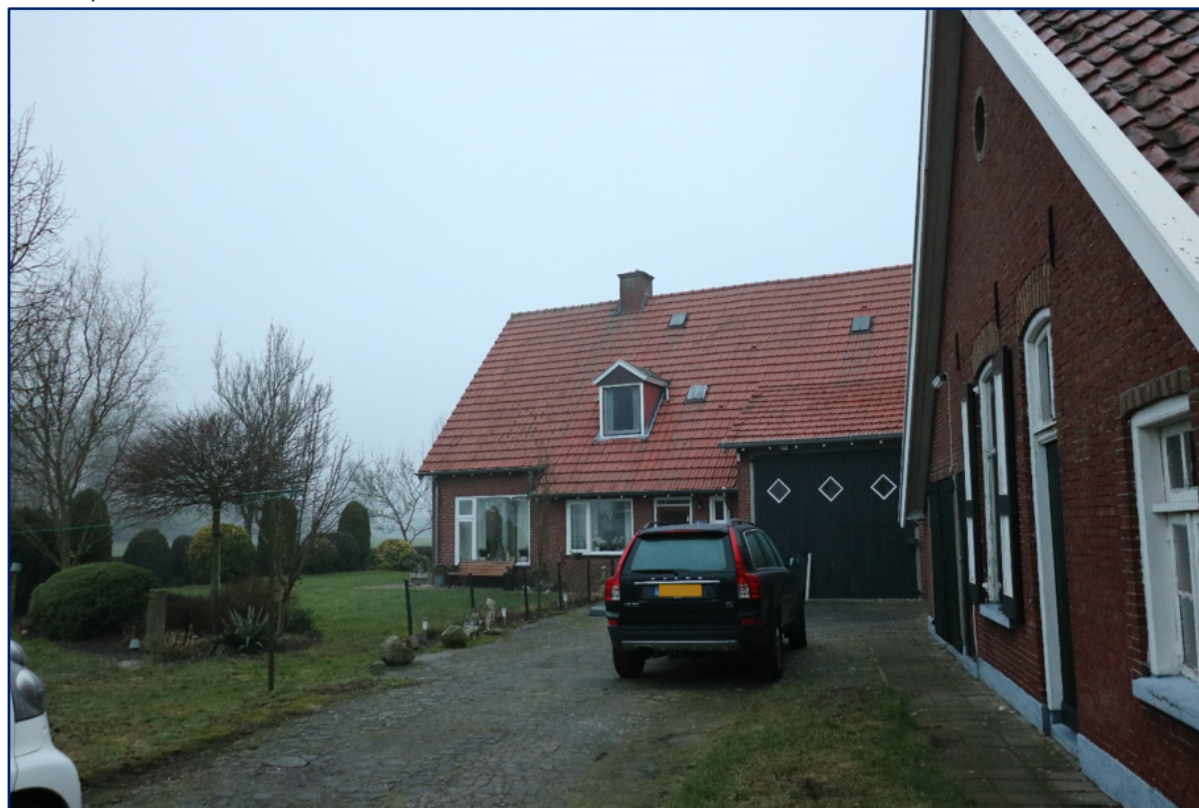
Figuur 2.6: Aanzicht Mastboersweg 4 vanaf voorzijde oude boerderij (bron: Ad Fontem)
