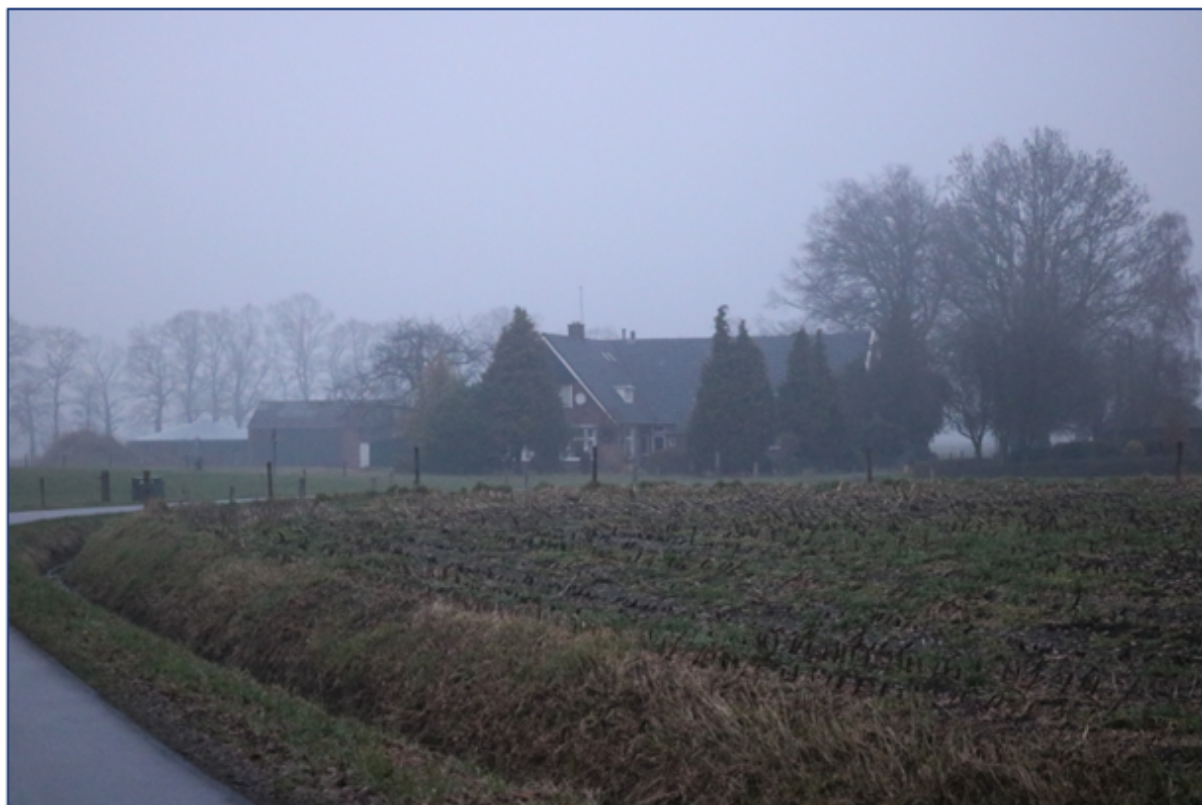
Figuur 2.2: Aanzicht Mastboersweg 1 vanaf de Mastboersweg ten zuiden van het plangebied (bron: Ad Fontem)
