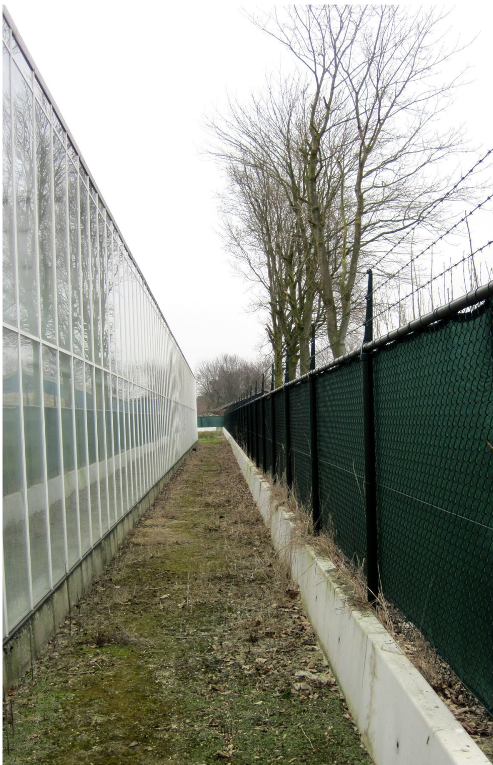
B5. Achter de kas is tegen de grondwal om de aangrenzende bedrijfslocatie een keermuur met daarop een hekwerk aangebracht. Deze wordt gehandhaaft. Voor de keermuur wordt een afwateringsgreppel aangelegd met een afvoer richting een infiltratieveld.
