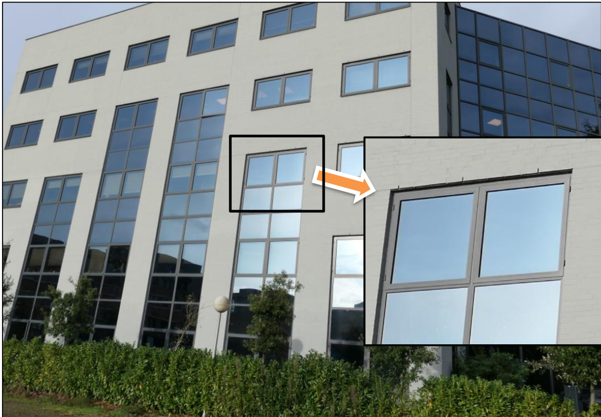
Figuur 4.2 Gebouw met open stootvoegen ten westen van plangebied.
