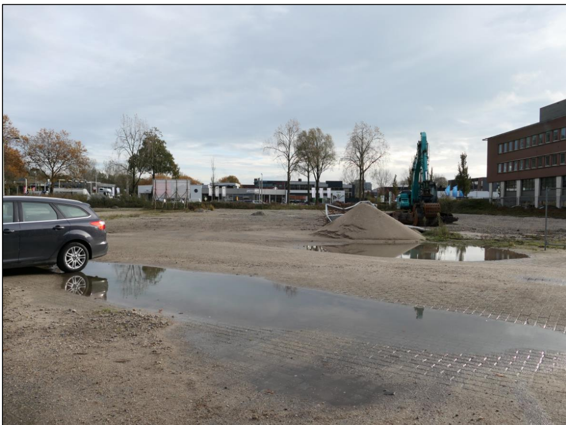
Figuur 1.6 Plangebied gezien vanaf het zuiden.
