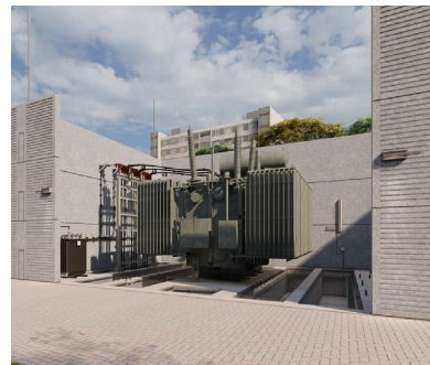
Impressie Station Liander met installatieruimte en transformatorruimten Dit is geen exacte impressie van het nieuwe 150kV/50kV station.
