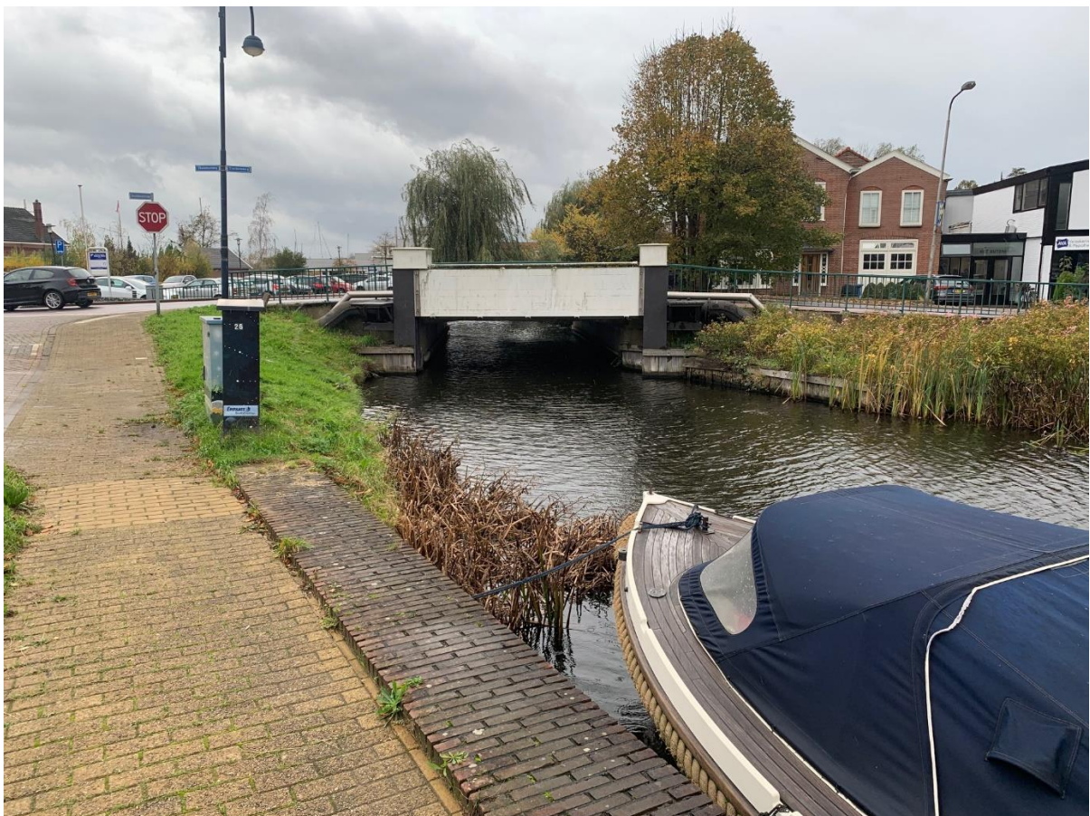
Figuur 5.11 Sluitbare waterkering in Aalsmeer
