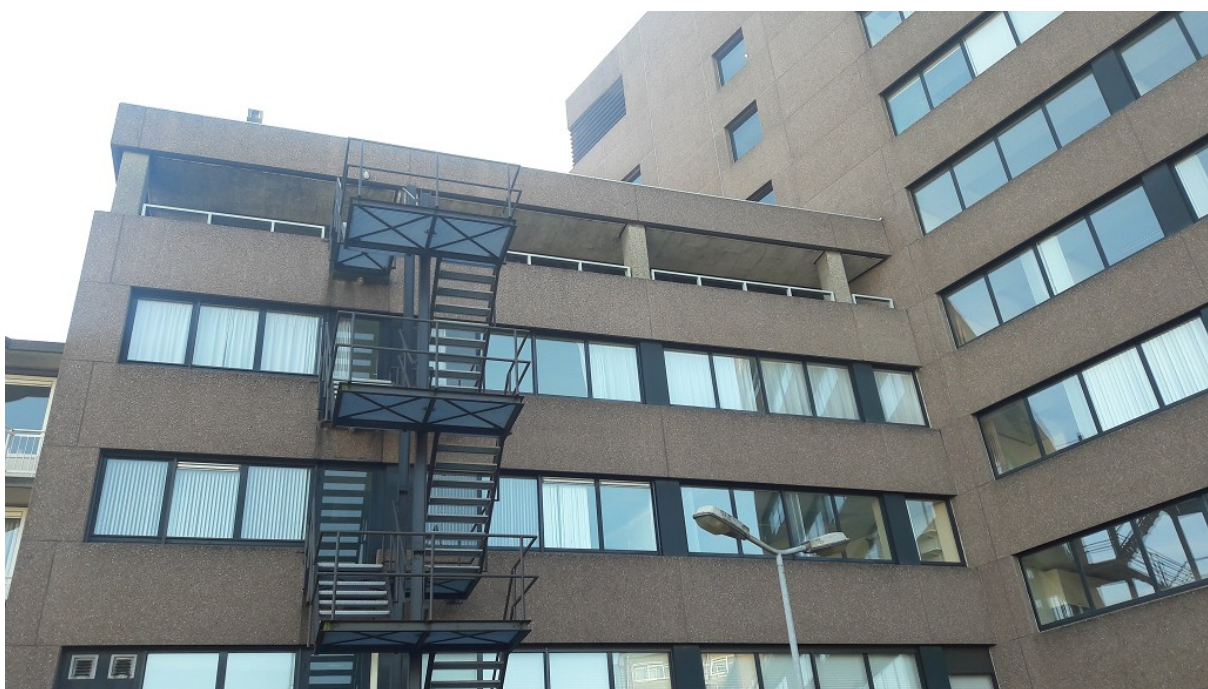
Gevel aan de binnentuinzijde met brandtrappen.
