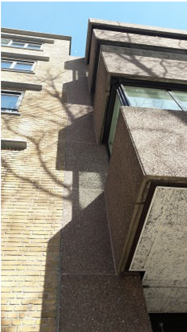
Gesloten voegwerk zonder geschikte invliegopeningen voor vleermuizen.
