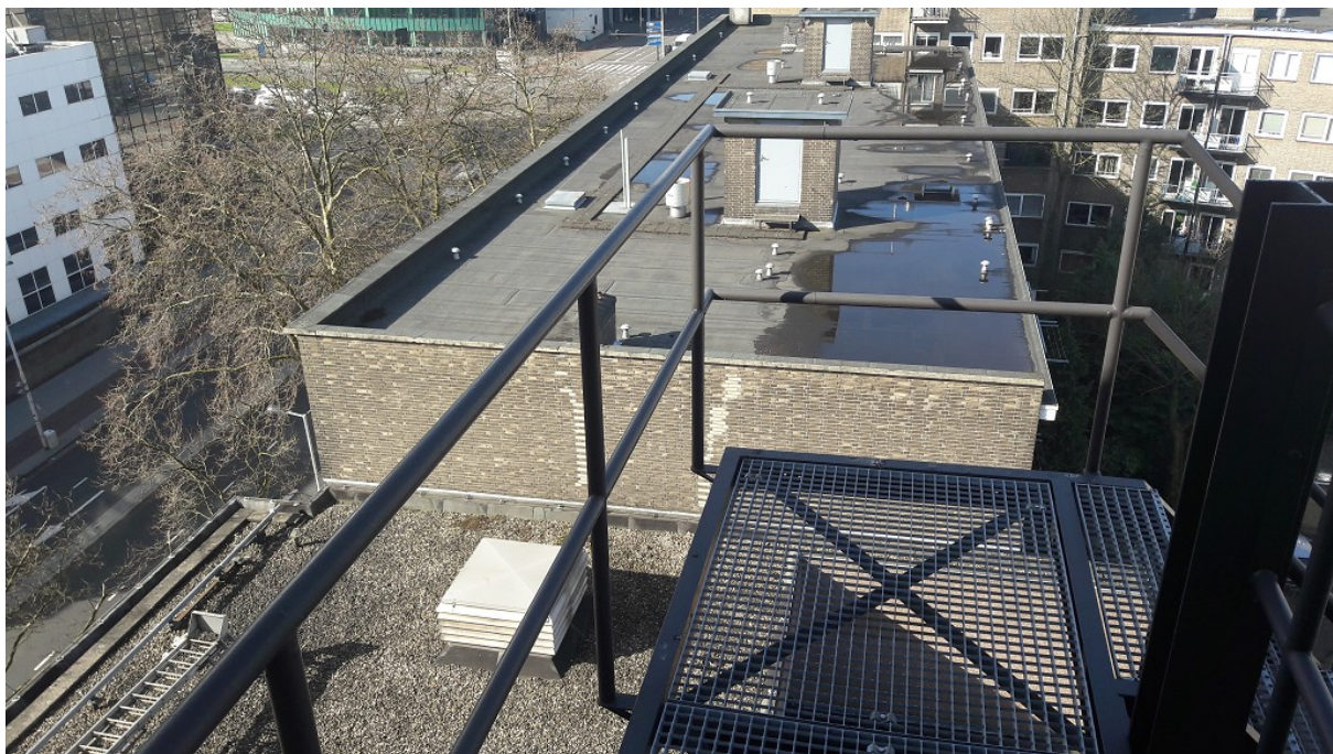
Westzijde van het plangebied vanhet dak af gezien. De bakstenenmuur is de grens van het plangebied.
