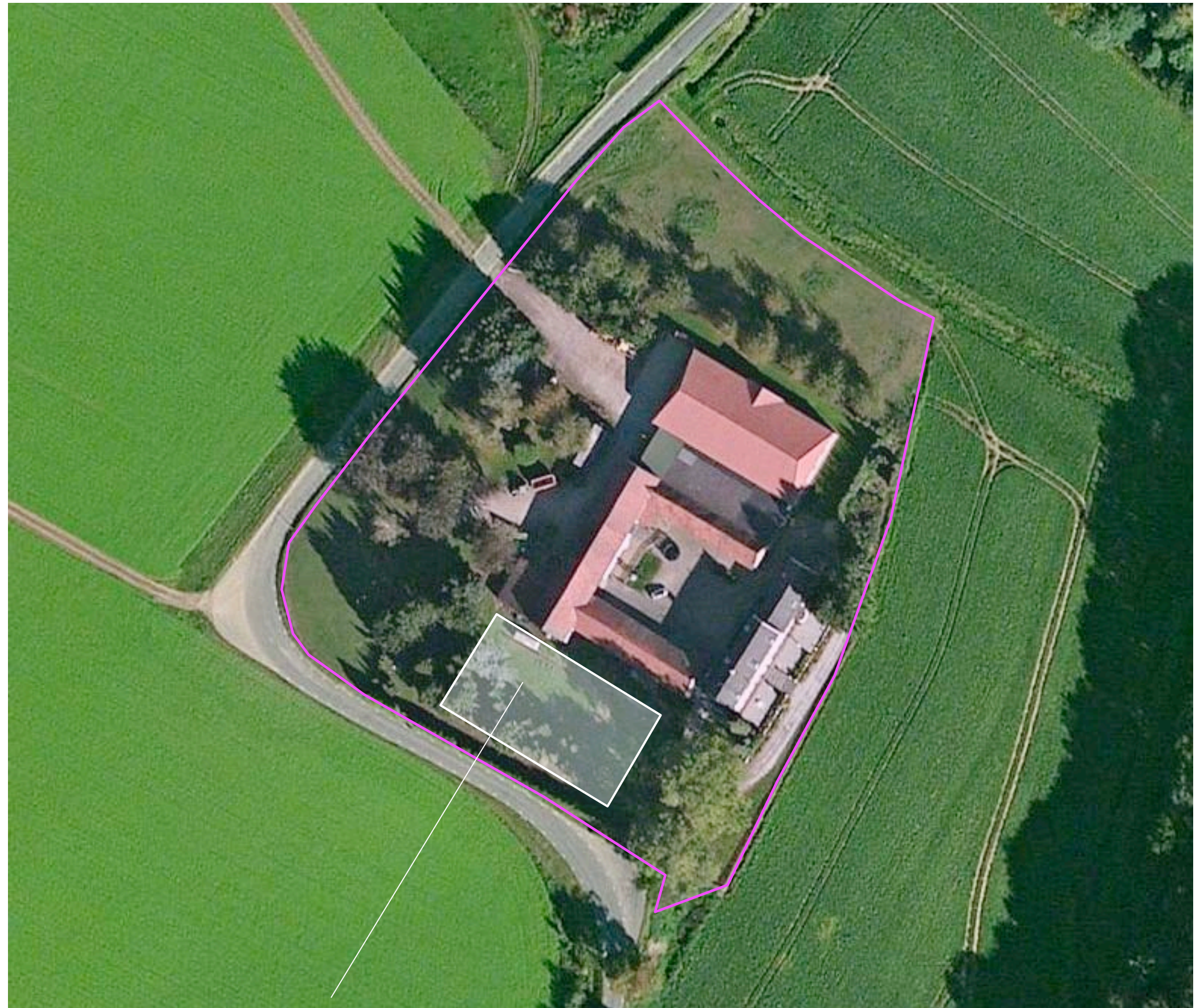
te realiseren loods
