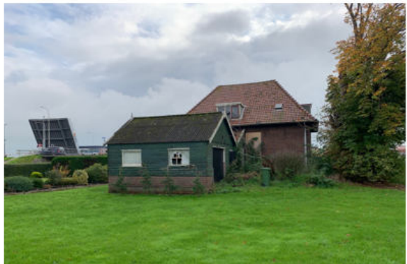
Achterzijde te slopen woning.
