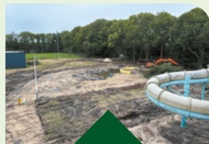
Straatwerk, grasveld en bosschages worden verwijderd.
