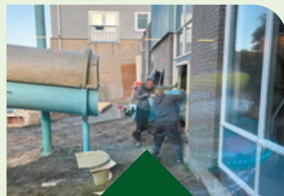
De glijbaan wordt gesloopt en de buitengevel dichtgezet.
