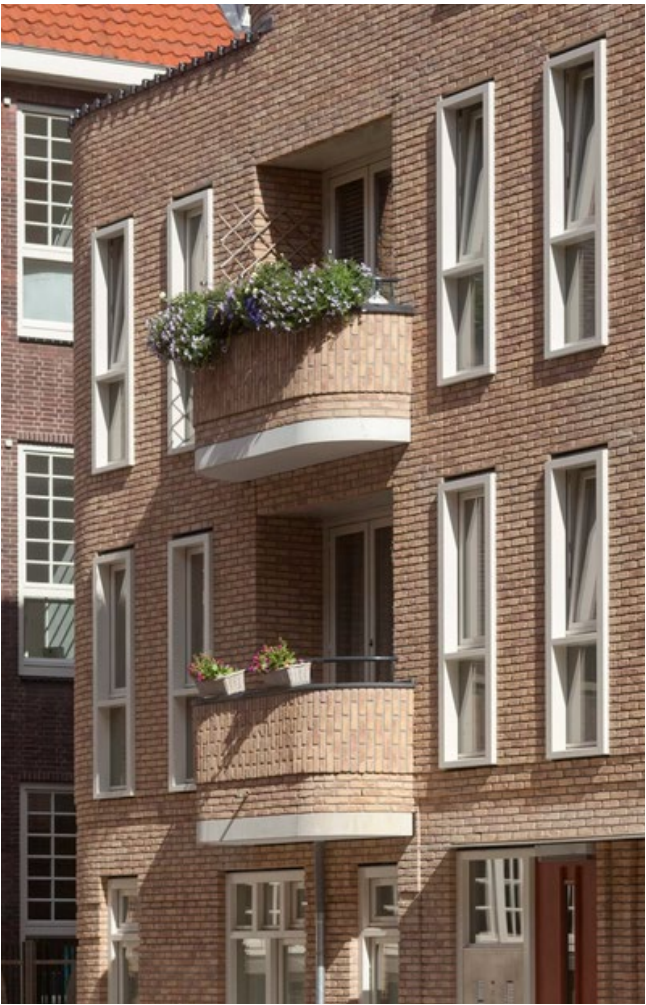
Balkons en erkers passen in materiaal en detail bij de rest van het gebouw en hebben gemetselde borstweringen.
