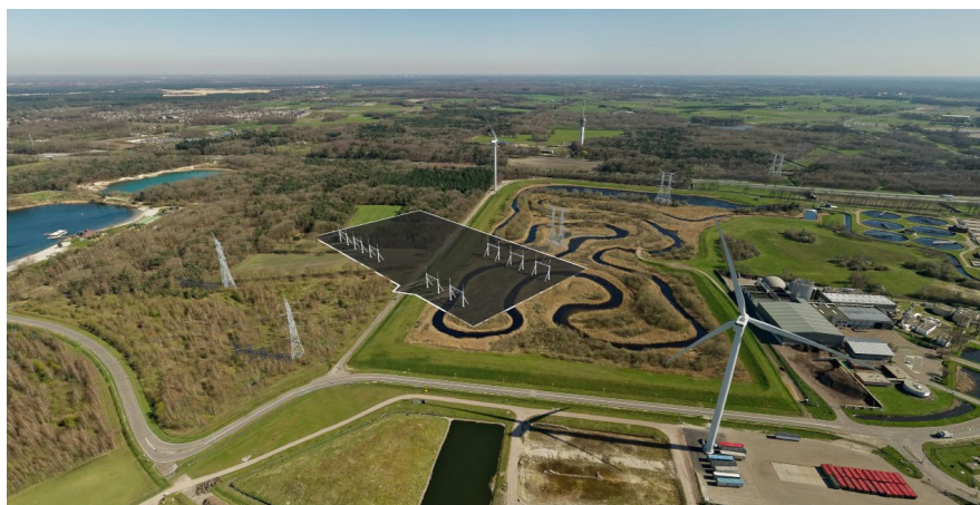
380 kV station Tilburg-Noord met opwek van windenergie
