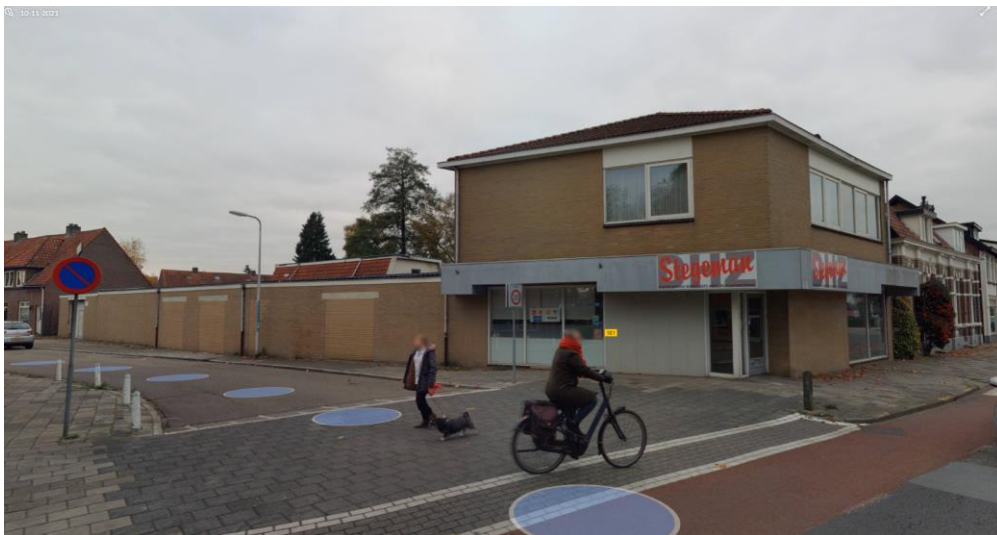
Figuur 1 Bestaande situatie
