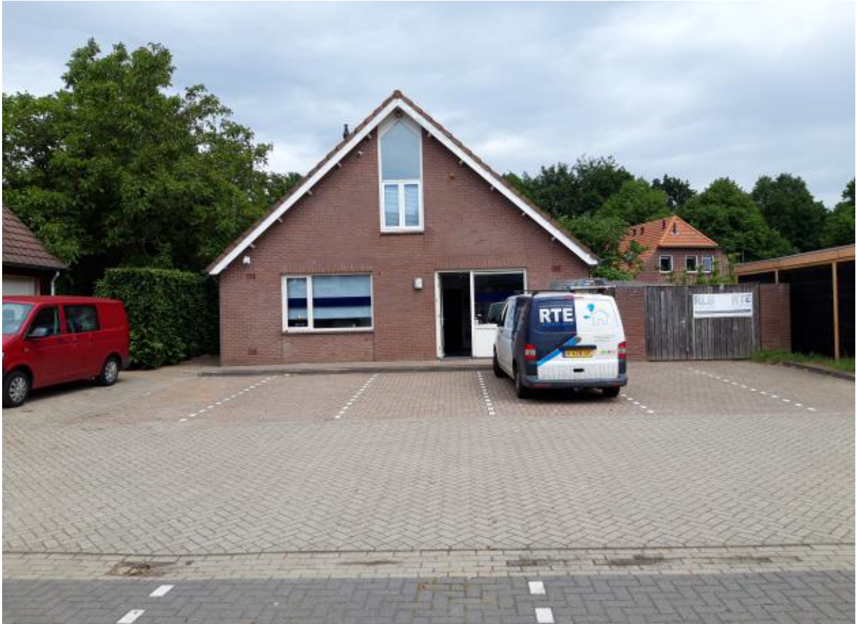
Het kantoor gezien vanaf de Bouwsteeg (foto: Van Dijk Milieutechniek)
