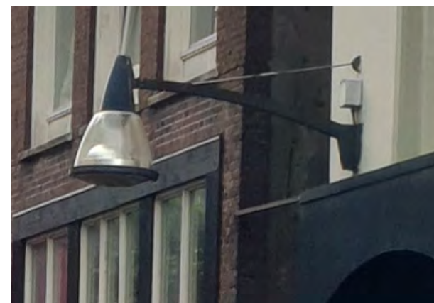
Handhaven verlichting aan de gevels
