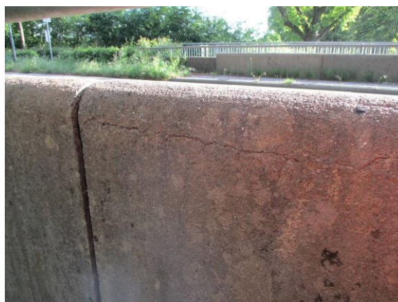
Foto 30 Scheur borstwering
