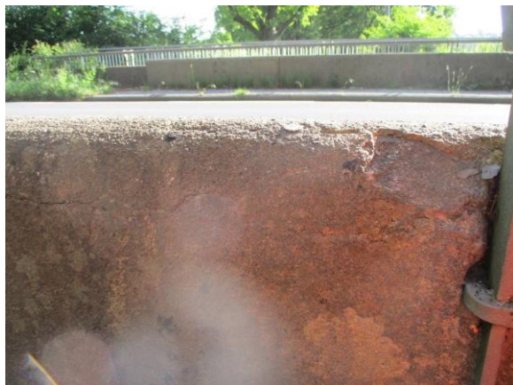
Foto 31 Betonschade borstwering
