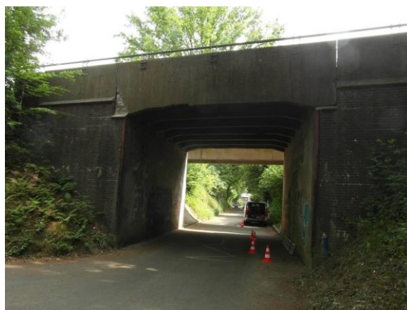
Foto 2. Westelijk aanzicht viaduct
