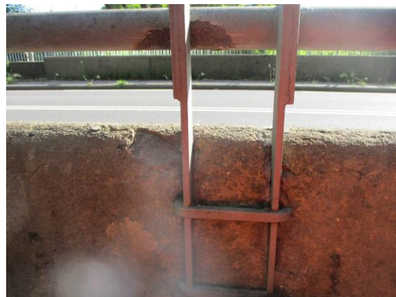
Foto 32 Betonschade borstwering
