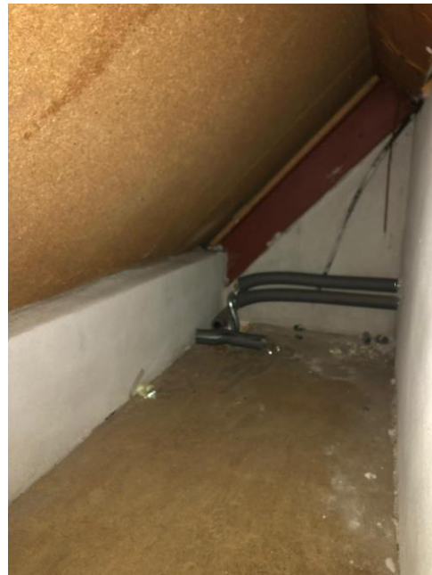
Figuur 26e: Inspectie verborgen ruimten zolder.
