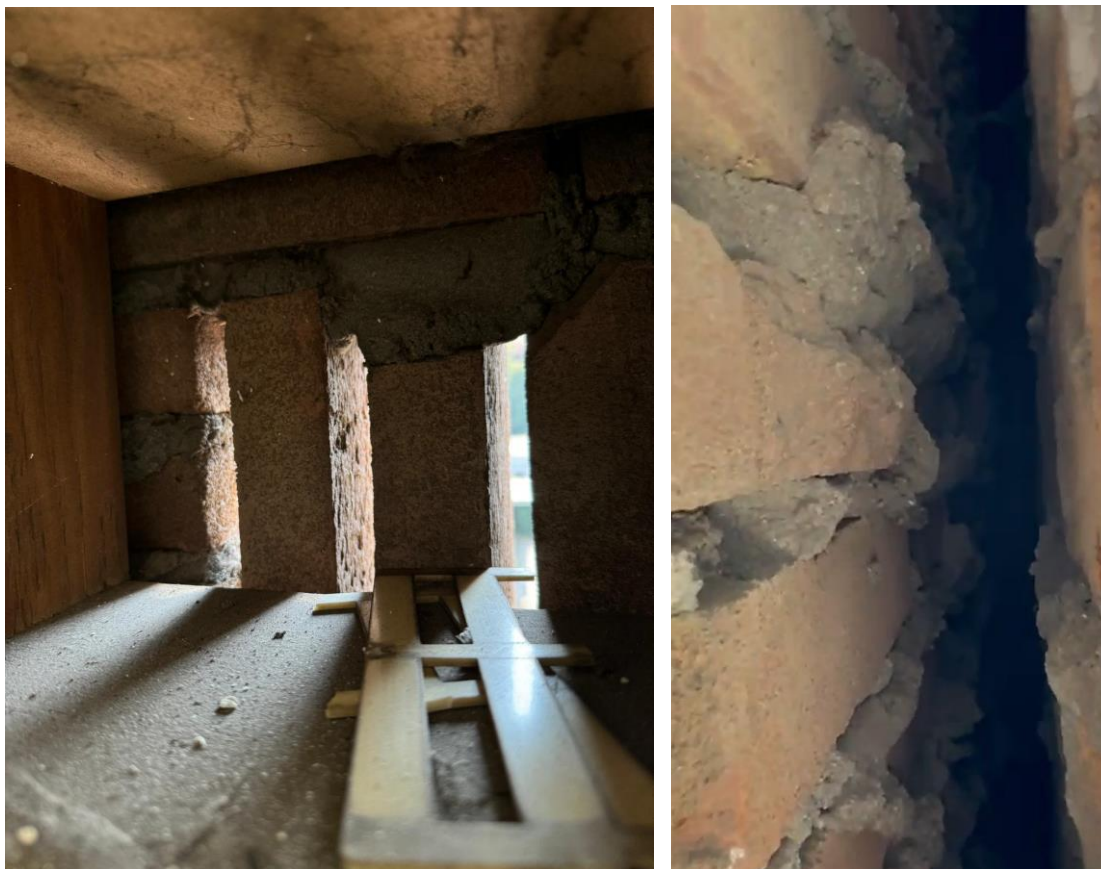
Figuur 26b en c: Open structuren van de buitenste muur van gebouw 120 van binnen uit gezien. Achter deze open structuren heeft een inspectie van de spouw plaatsgevonden (rechter deel bovenste foto's). Er zijn géén sporen van vleermuizen, zoals mest of prooiresten, aangetroffen. De spouw is tochtig door de verschillende open structuren en derhalve niet geschikt als verblijfplaats voor vleermuizen.
