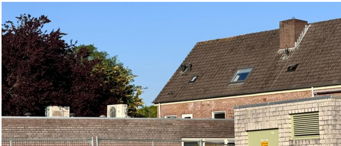
Figuur 1: Zicht op de achterzijde d.d. 14-4-2025.
