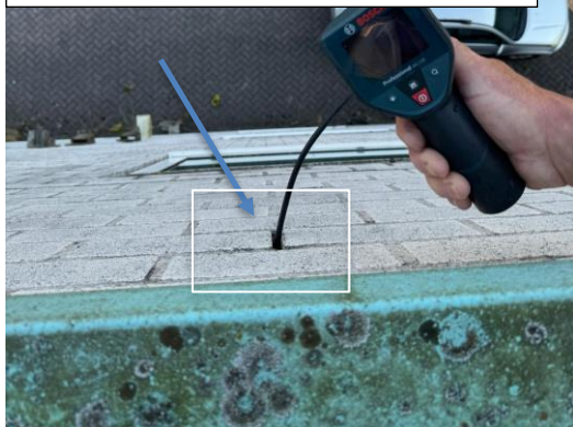
Figuur 25a: Interne inspectie Gebouw 122.
