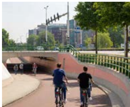
fiets tunnel onder Ceintuurbaan
