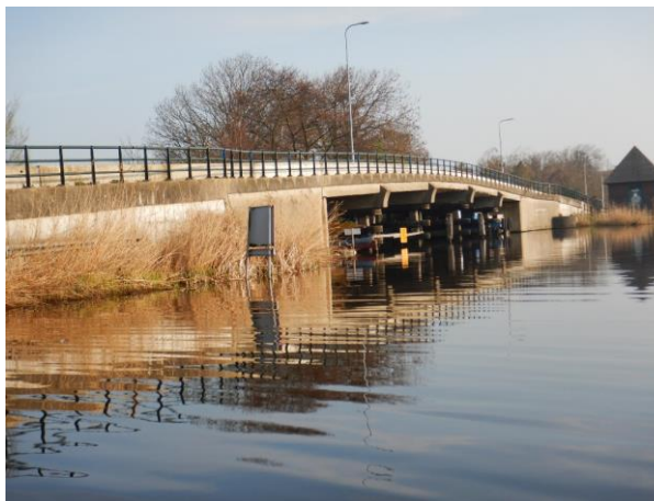
Figuur 2.3: Overzichtsfoto vanaf zuidzijde Stringsloot
