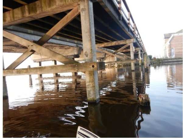
Figuur 2.8: Onderzijde fietsbrug
