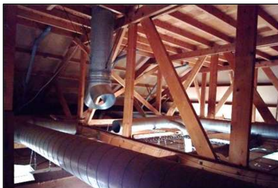
Afbeelding 2.15. Ruimte boven het systeemplafond
