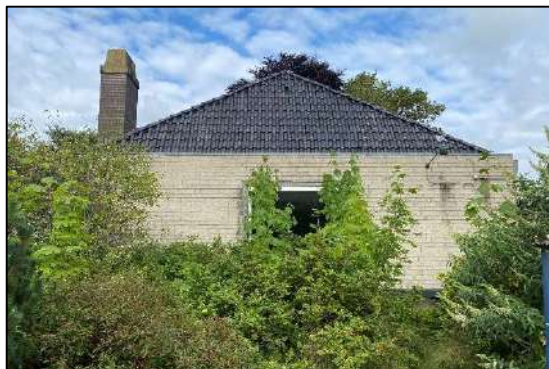
Afbeelding 2.2. Oostzijde van het gebouw
