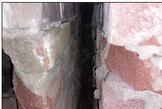
Afbeelding 2.14. Spouwmuur
