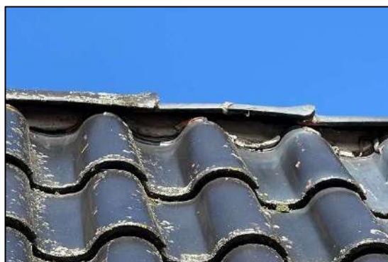
Afbeelding 2.9. Dichtgemetselde nokvorsten
