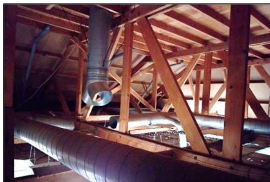
Afbeelding 2.15. Ruimte boven het systeemplafond
