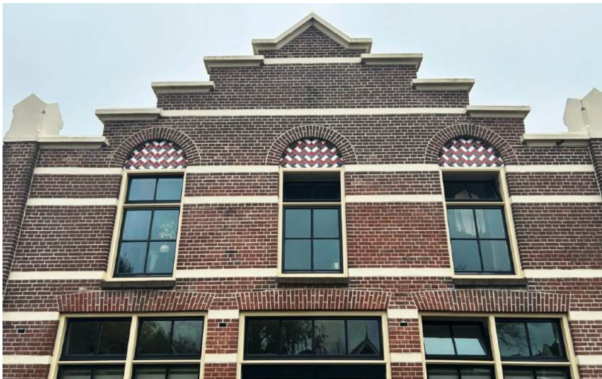
Deel van de gevel van de Noord-Hollandsche Conservenfabriek aan de Voorburggracht in Noord-Scharwoude (foto: gemeente Dijk en Waard).
