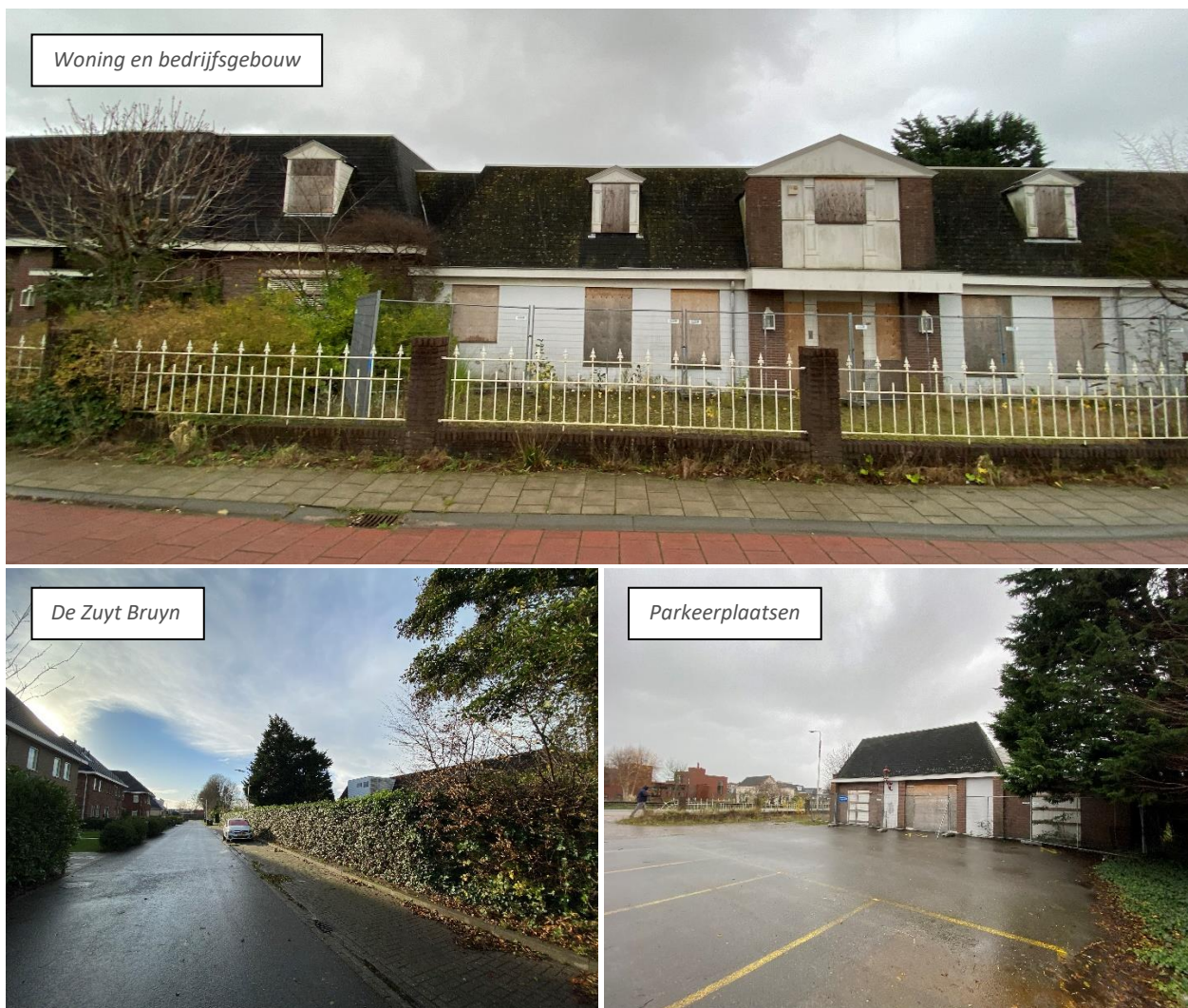
Afbeelding 2.2: Foto's bestaande situatie
