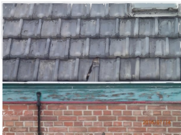
Foto 7. detail dakpannen Sand-Ambachtstraat 87
