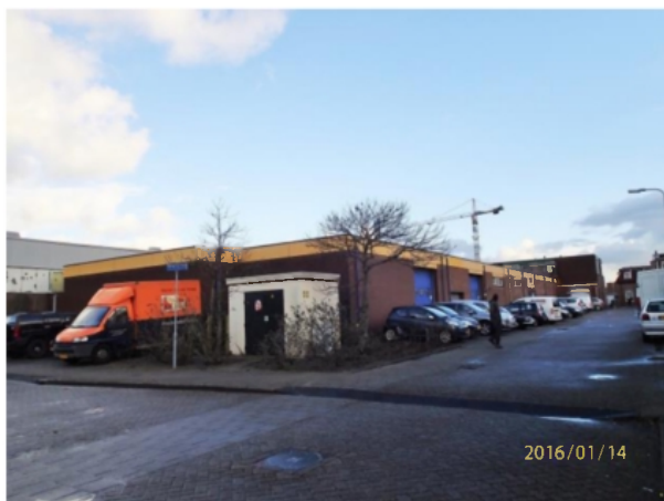
Foto 3. Hoogspanningskast Van der Hostweg
