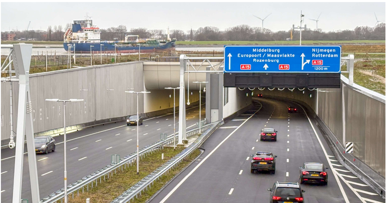
Maasdeltatunnel, gezien vanaf het noorden. Foto: Rijkswaterstaat
