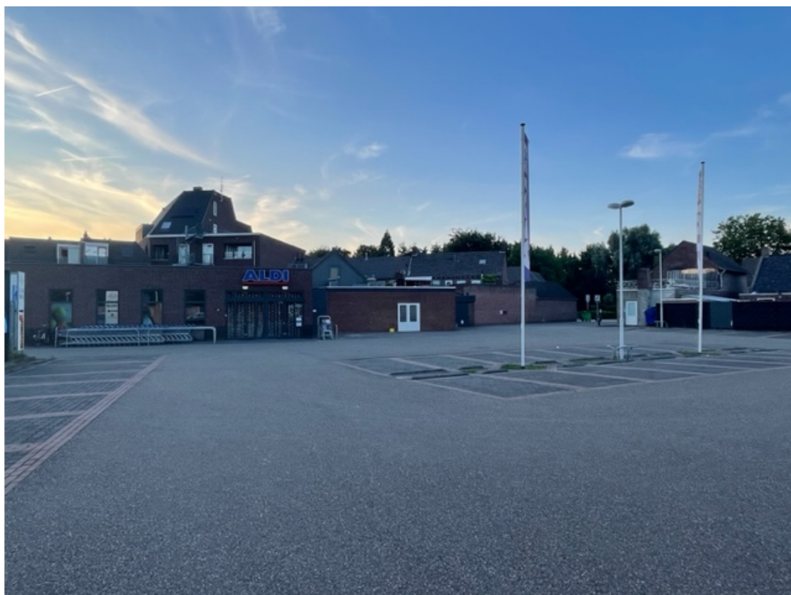
Figuur 2.9 Parkeerterrein aan de achterzijde van de Julianastraat en Emmastraat, zicht op het noorden
