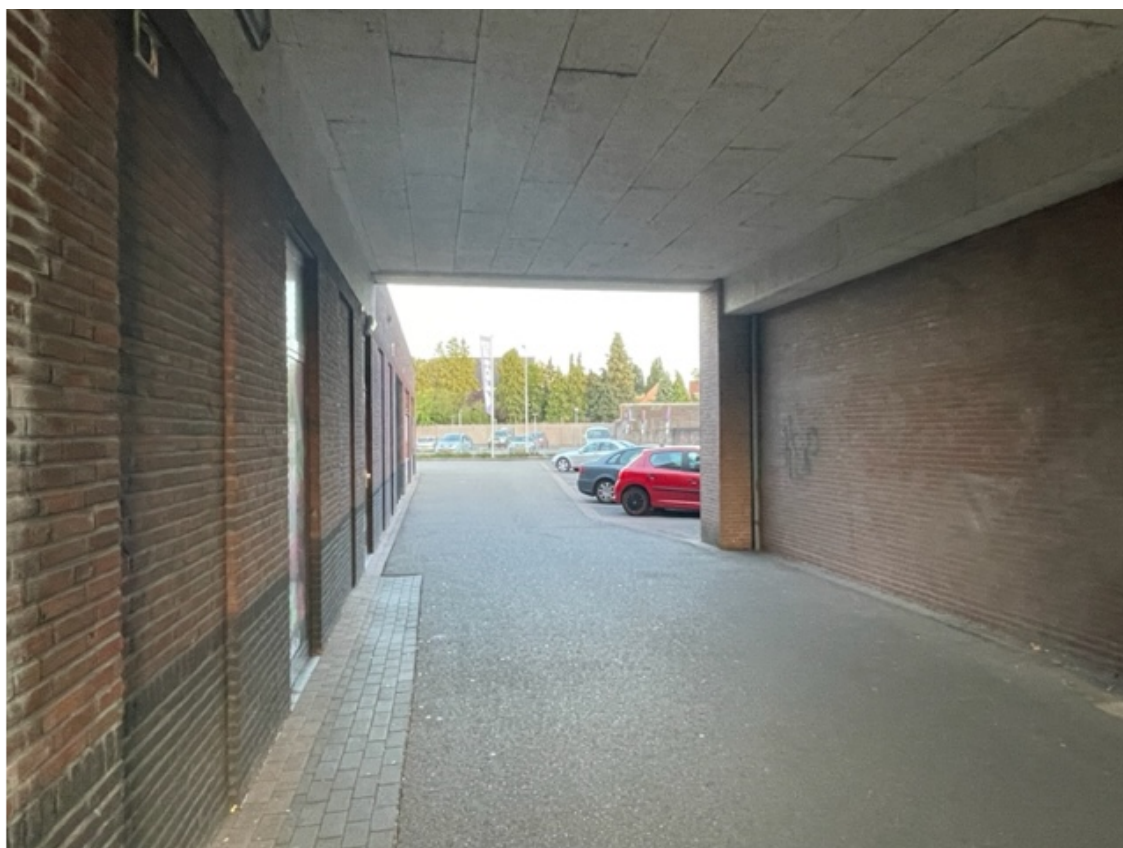
Figuur 2.8 Bestaande onderdoorgang richting zuidelijk parkeerterrein
