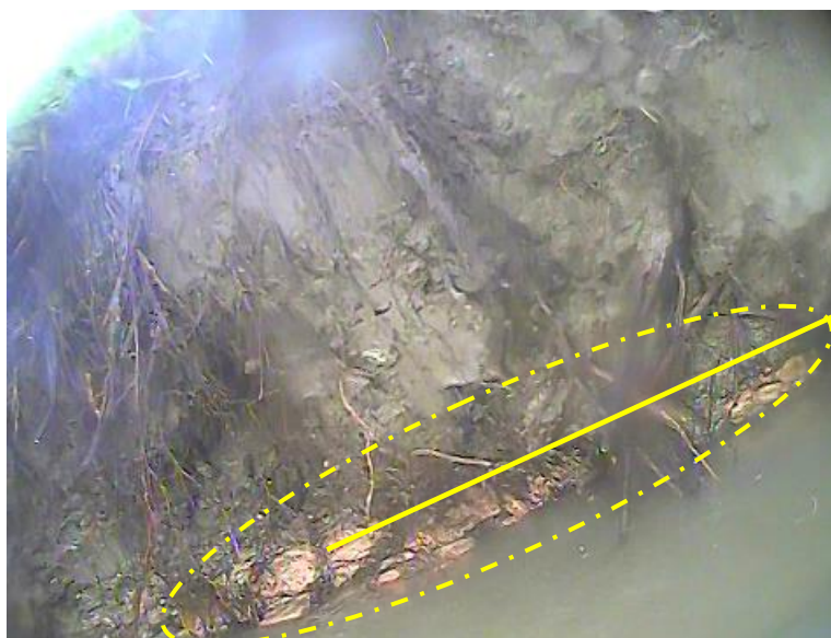
Foto 8 – Oude steenlagen in het bolwerk (noordwestzijde)
